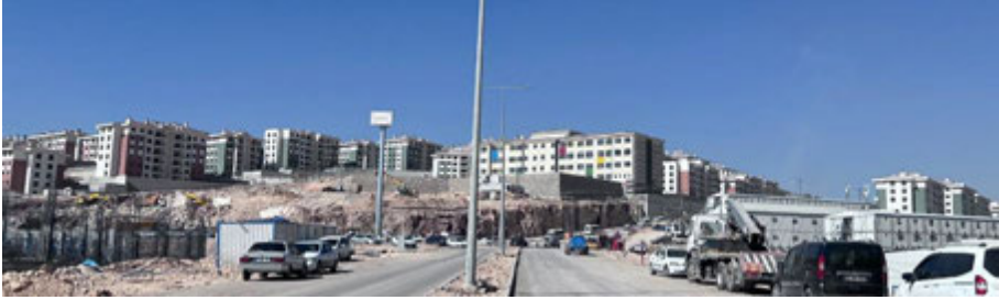
Fotoğraf 3-10 İndere Kalıcı Deprem Konutları Konut İnşaatları
