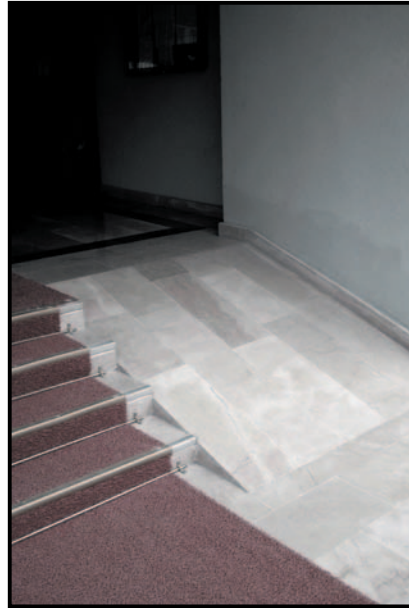
Standarta uygun olmayan eğim ve malzeme ile yapılmış bir rampa
