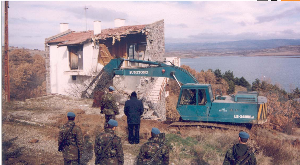
Yıkım çalışmalarından bir görünüm.
